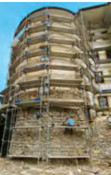
Utrditveni ukrepi na gradu v Škofji Loki
