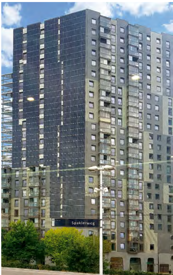
Trajnostna stavba z integriranimi PV paneli na fasadi (Amsterdam) (foto M. Šijanec Zavrl)
